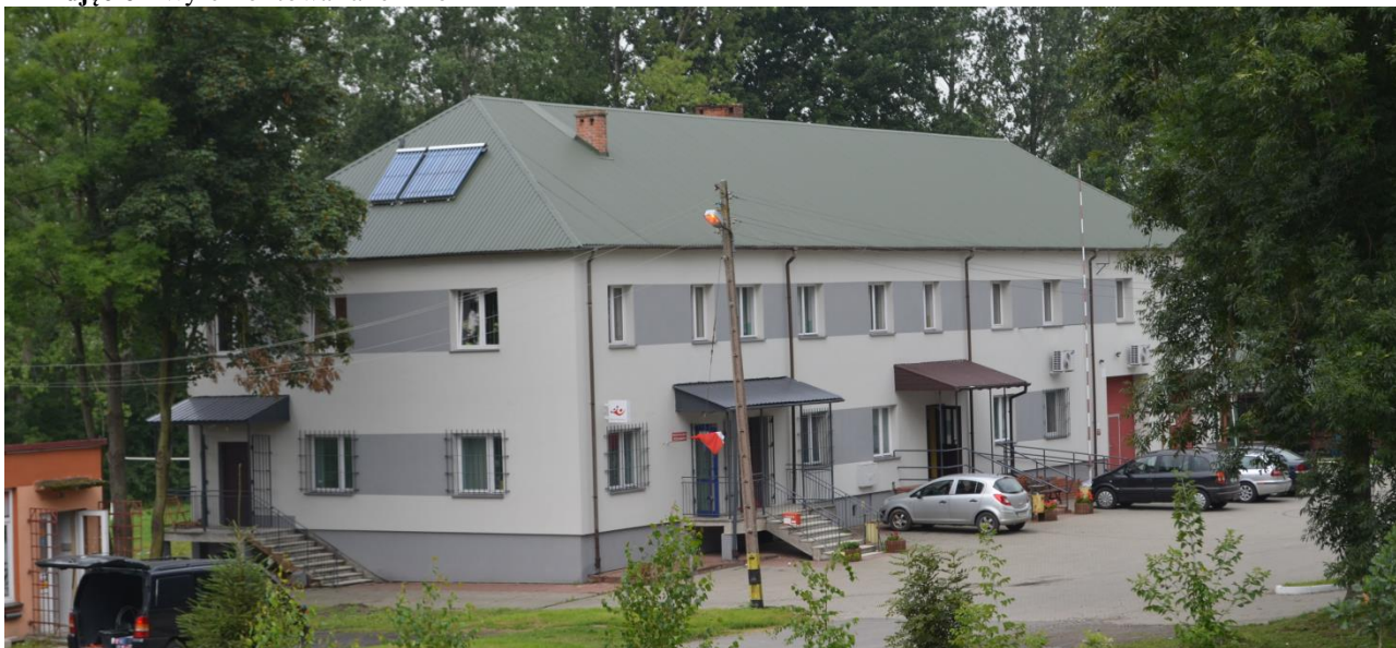
Zdjęcie 4 Wyremontowana remizo-świetlica w Sułowie
